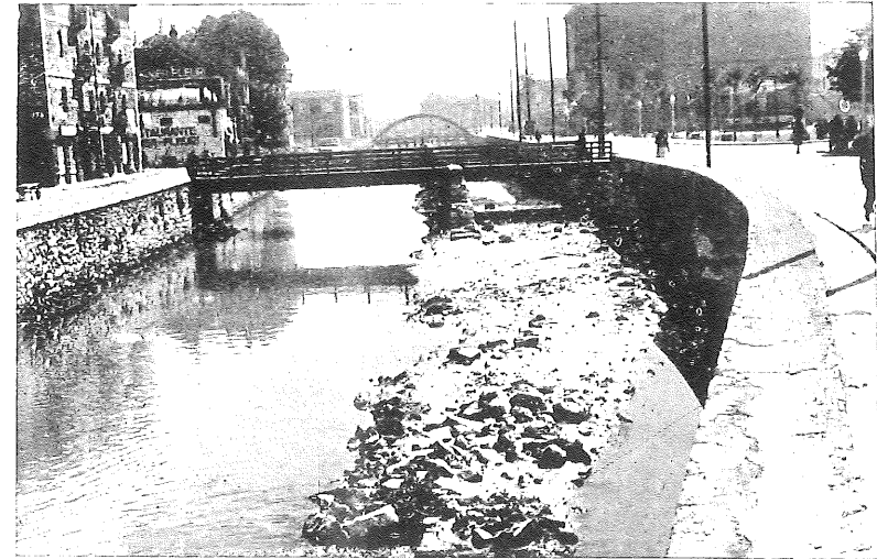
Fig. 13.—Rentería. Se halla situado en el cono de deyección del Oyarzun. La foto, tomada en la canalización reciente del último tramo del río, muestra la rapidez del enronamiento.
